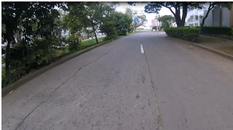
Imagen 57-Grieta longitudinal sobre estructura de pavimento rígido – Tramo Calle 34 entre Av. 6 y Av. 3N
