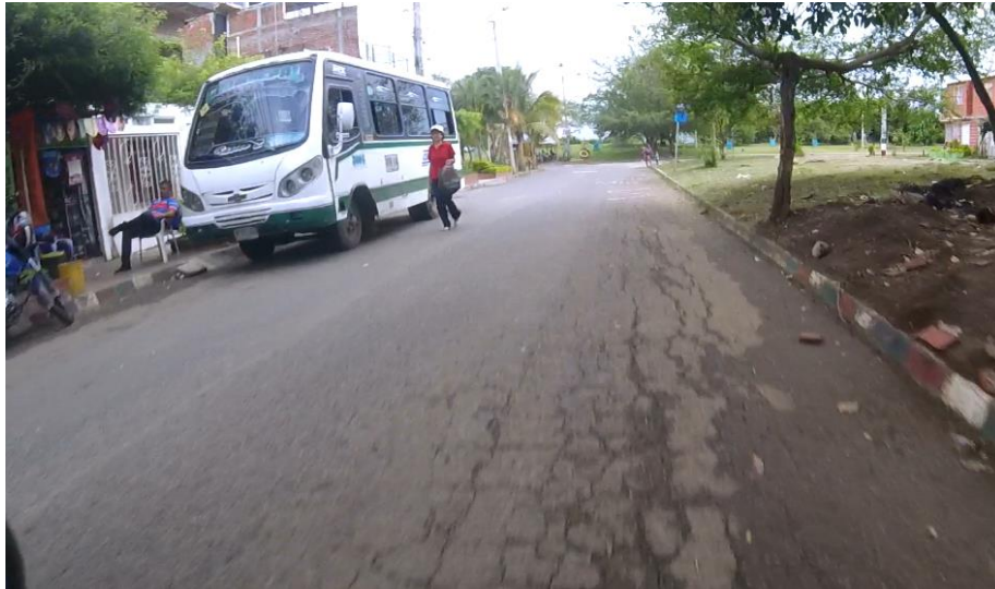
Imagen 57-Grieta longitudinal sobre estructura de pavimento rígido – Tramo Calle 34 entre Av. 6 y Av. 3N
